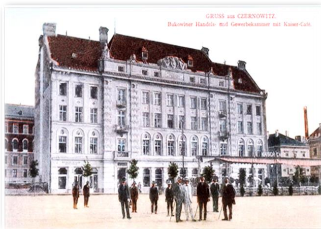
Будівля торгової палати, а перед нею - намет літньої кав'ярні «Кайзер». Фото 1912 року.
