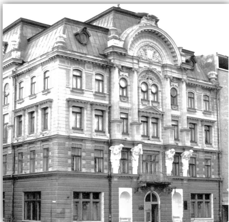
Будівля на Театральній площі, 6, у якій в довоєнний період знаходився Єврейський дім. Фото 1946 року.
