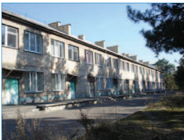
Інфекційні відділення ДКЛ № 2, вул. А. Навої, 2 (105 ліжок); I відділення (боксоване) — 60 ліжок; II відділення (кишкових інфекцій) — 40 ліжок
